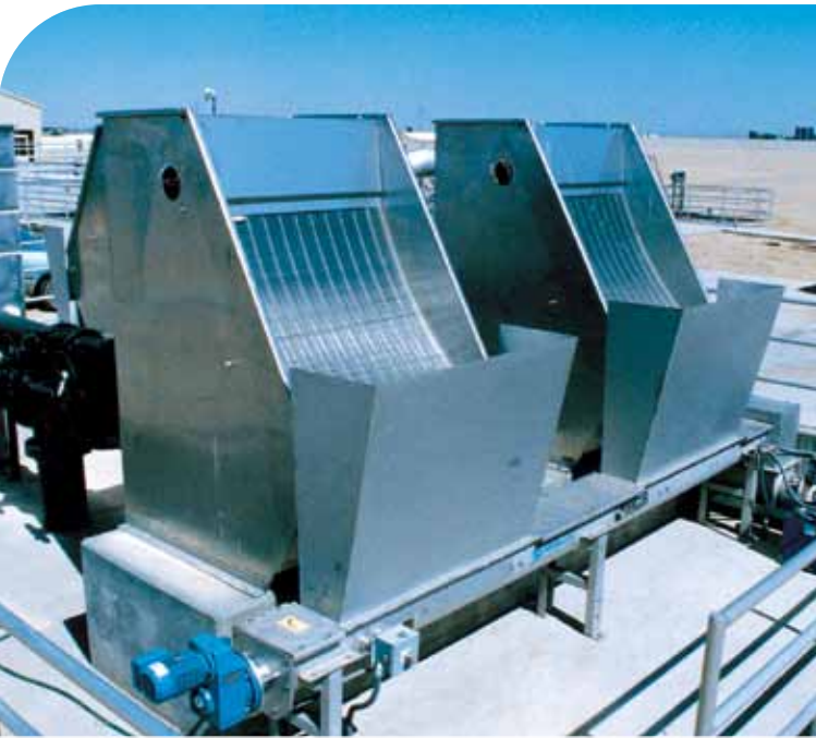
Sistema de transporte y desaguado con rejilla inclinada de alta capacidad con malla de alambre tipo cuña de doble onda
